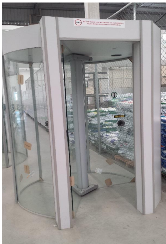
Figura 16. Vista parcial da porta giratória com detector metais.
