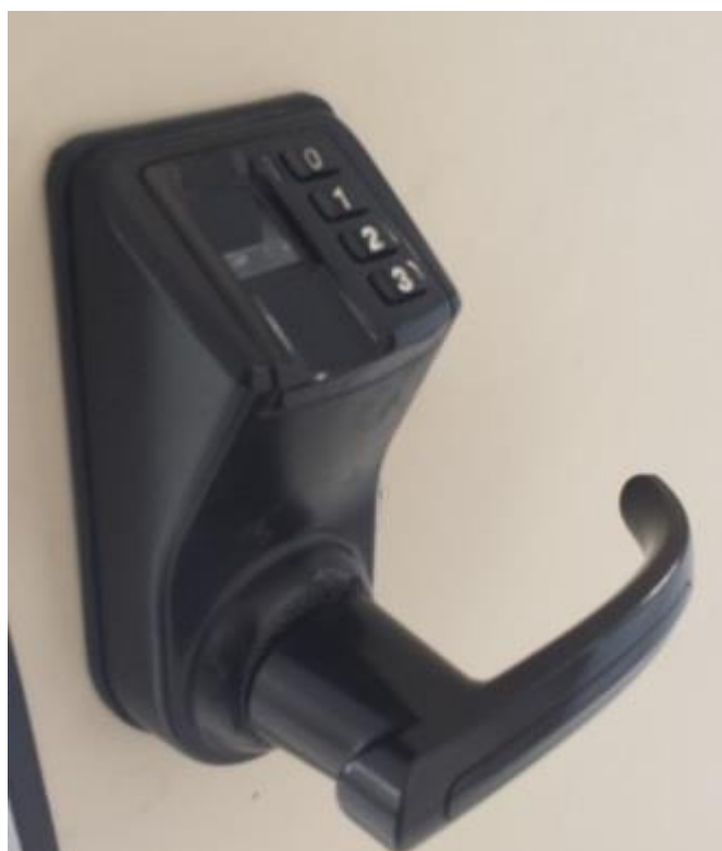
Figura 17. Equipamento biométrico de controle de acesso à sala de digitalização.
